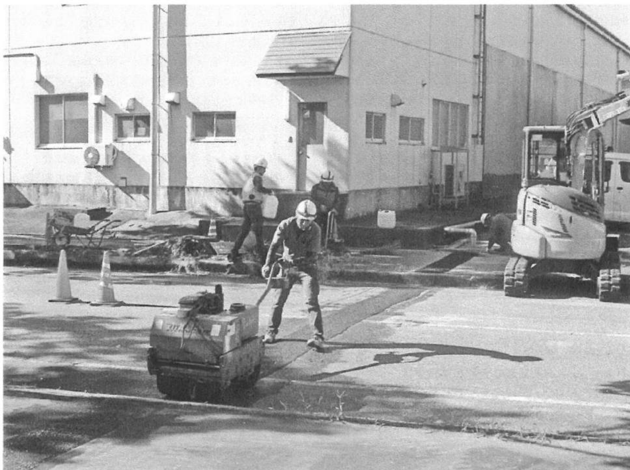
9/17～ 消雪補給水管道路横断工事
